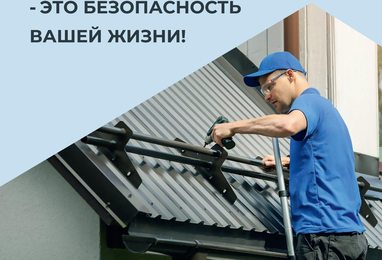
Снегозадержатель – один из важнейших элементов безопасности кровли. Он несет защитную функцию и придает дому законченный вид.
